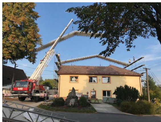
Stavba lešení a provizorní střechy 19. 9. 2018
